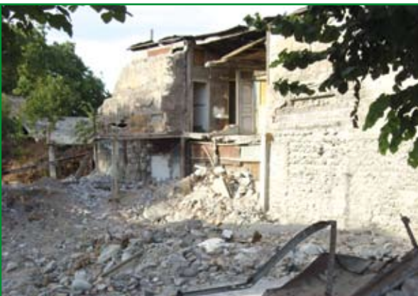
▲ Типичный вид жилого дома в Цхинвале. 80% разрушений пришлось именно на гражданские объекты. И Запад с его «гуманизмом и демократией» будет выгораживать Саакашвили? Тогда рекомендуем пожить вот в таком доме!
